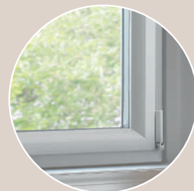
Fenêtre avec paumelle visible
